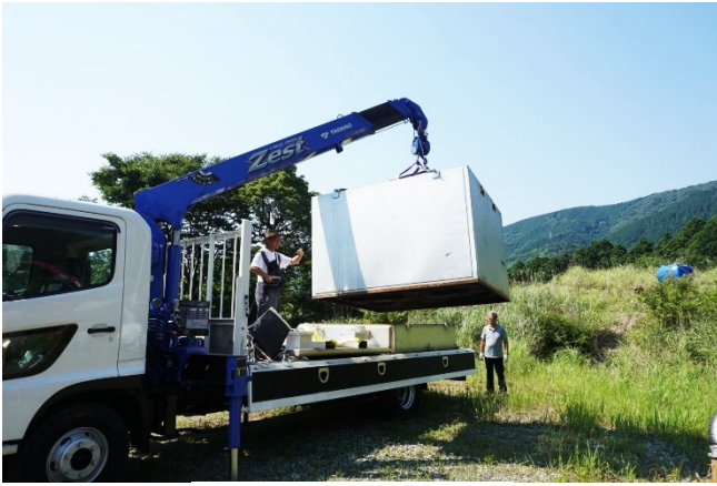
4tトラックで移設可能
